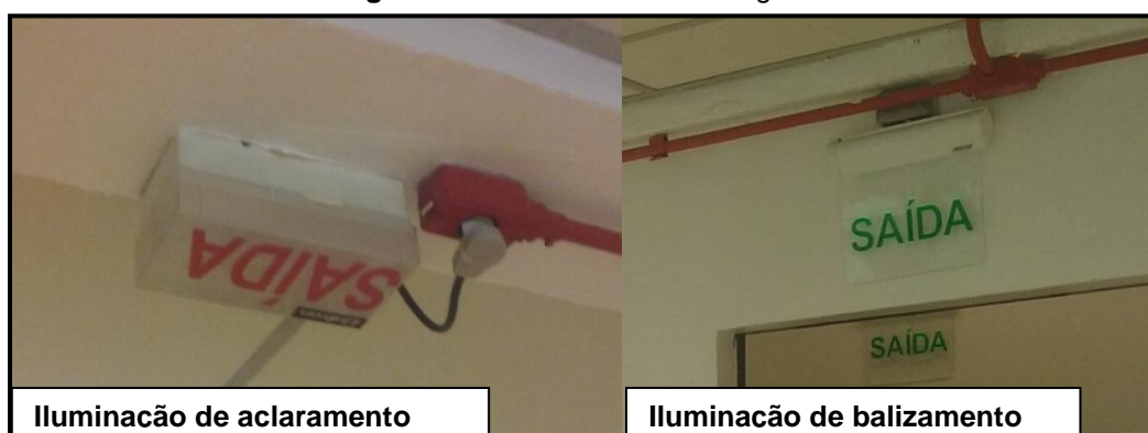
Figura 38 - Luminárias de emergência
