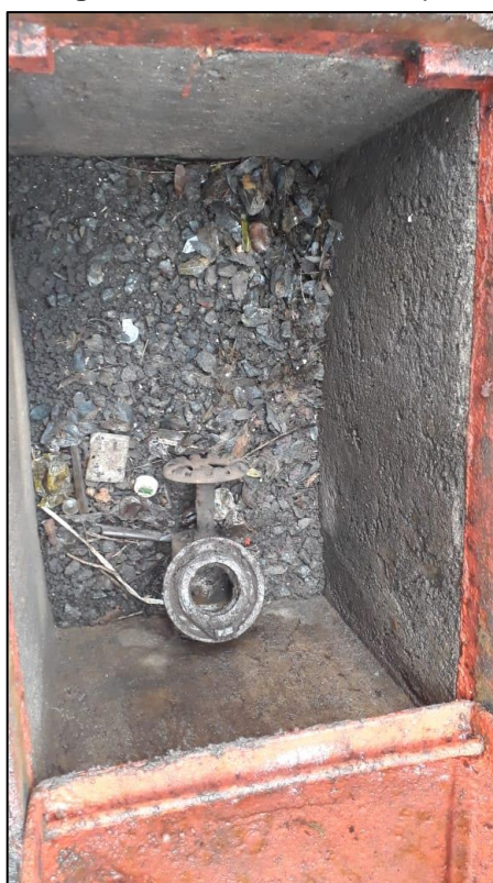
Figura 51 - Válvula de recalque
