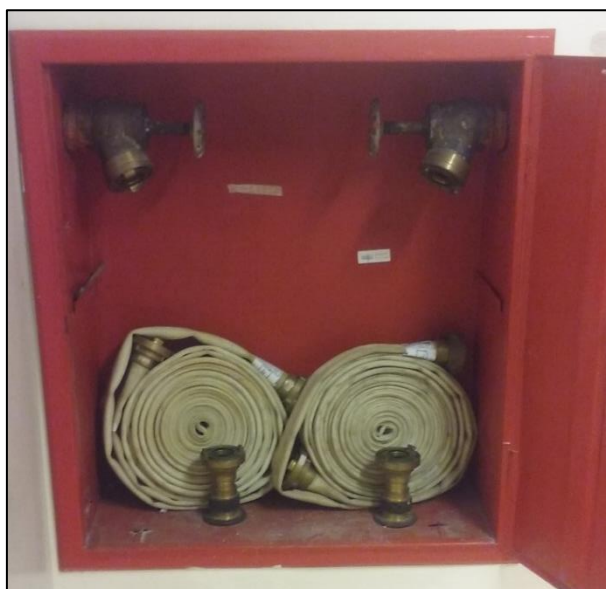
Figura 48 - Abrigo do hidrante.
