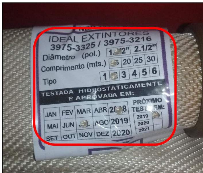
Figura 49 - Selo de aprovação no teste hidrostático
