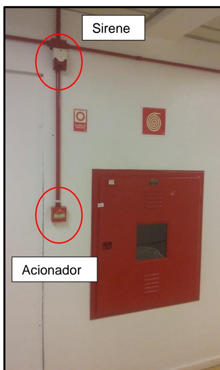
Figura 40 - Acionador e sirene de incêndio
