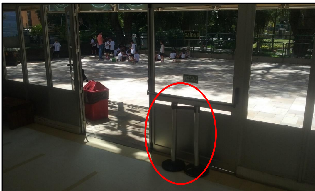
Figura 34 - Saída de emergência com obstrução
