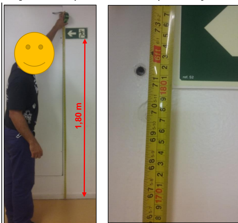
Figura 42 - Indicação de altura da sinalização de emergências
