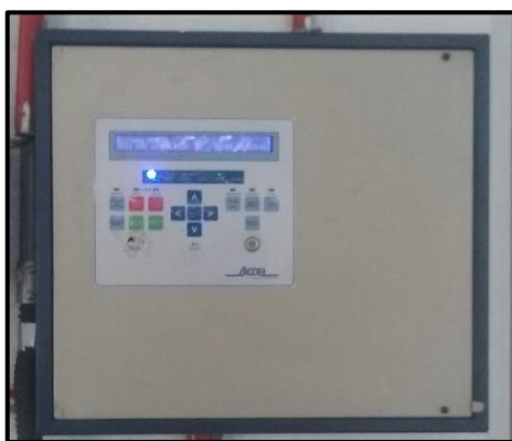
Figura 41 - Central de alarme de incêndio
